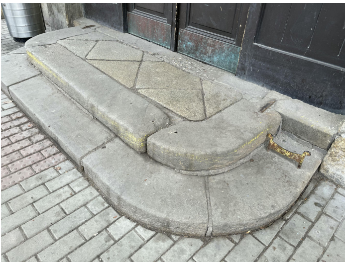
PÍSKOVCOVÉ BLOKY POD PERONÍM PŘÍSTŘEŠKEM (VIZ POZNÁMKA SOUČÁSTÍ SO 77-51-01)
