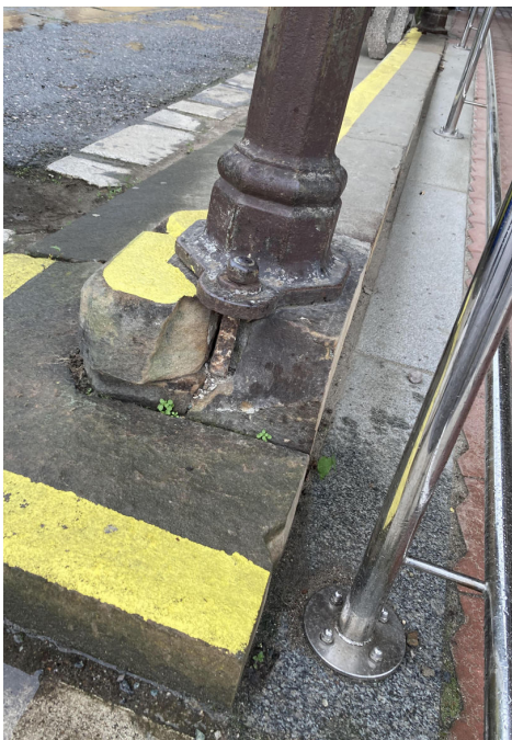
POŠKOZENÁ PATKA U SLOUPU PERONNÍHO PŘÍSTŘESKU
